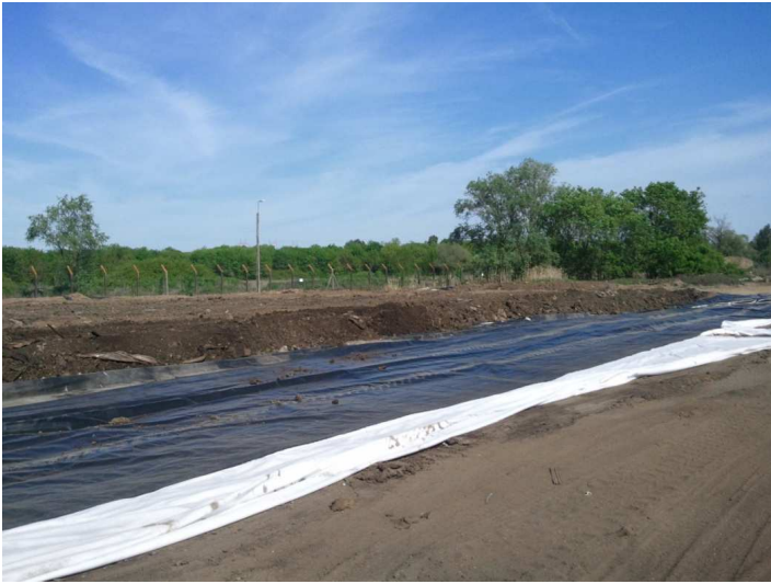
Exemple de la mise en place d'un complexe étanche.
