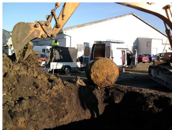
Démantèlement cuve à carburant
