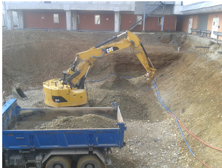
Opération d'excavation des terres polluées
